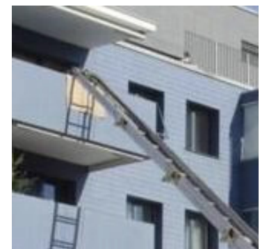
Balkonbrüstung aus Beton
