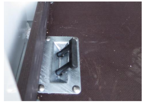
Bindebügel im Boden versenkt
