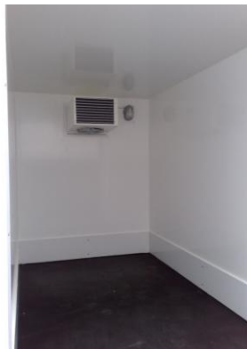
Rammschutz auf 3 Seiten
