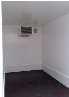
Rammschutz auf 3 Seiten
