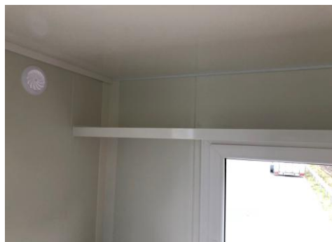
Ordnerablage über Fenster
