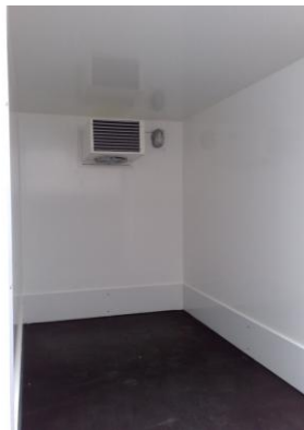
Rammschutz auf 3 Seiten
